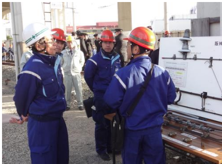
電車線断線復旧訓練視察（社長）
